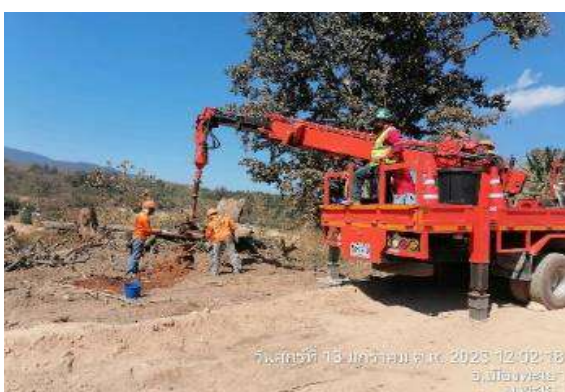
ติดตั้งเสาไฟฟ้า
