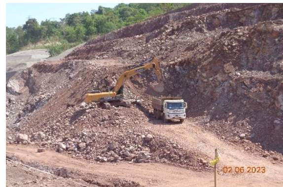
ปรับระดับ Excavation general/Slope Protection
